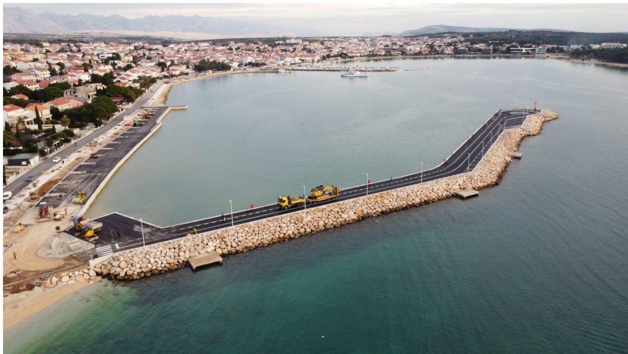
Slika 2. Postojeće stanje izgrađenosti luke Novalja (sjeverni dio)
